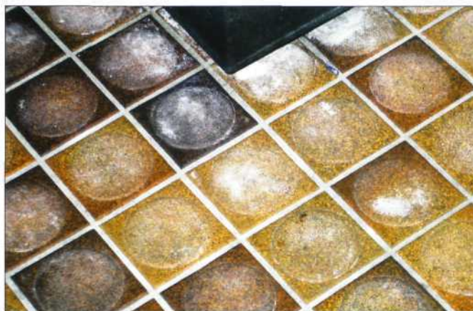
Kalkbeläge auf Fliesen: Bei schwer zu entfernenden Restbelägen ist zu bewerten, ob sie nur optisch stören oder etwa hygienisch bedenklich sind
